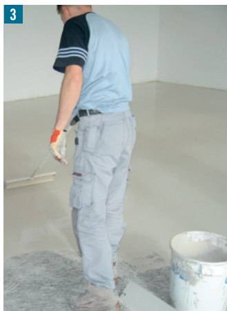
3 Sorgfältiges Entlüften des Fließspachtels auf der flächendeckend ausgelegten CS-Matte mit dem Stachelroller.
